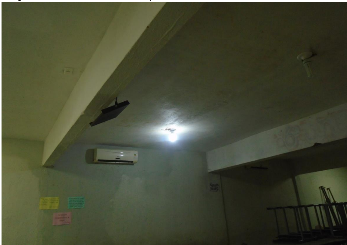
Imagem 15 – Foto tirada in loco da laje e parede do auditório no térreo. Fonte: COPROJ-SEINF.
