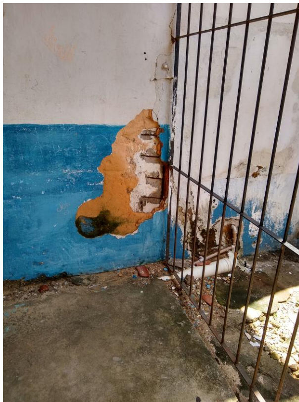
Imagem 10 – Foto tirada in loco da alvenaria externa. Fonte: COPROJ-SEINF.
