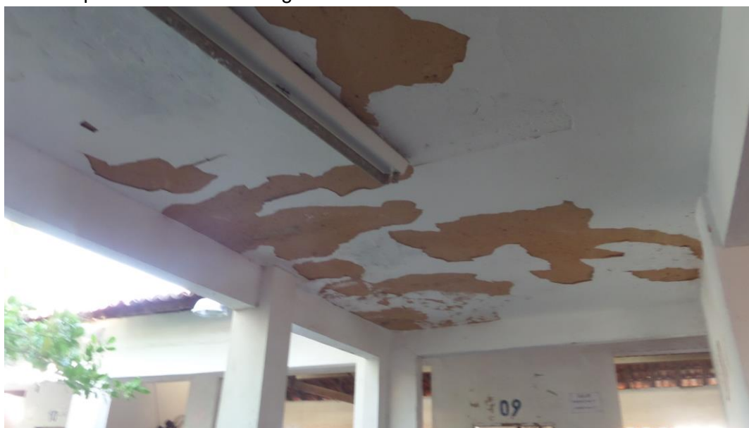
Imagem 07 – Foto tirada in loco da laje do primeiro andar. Fonte: COPROJ-SEINF.
