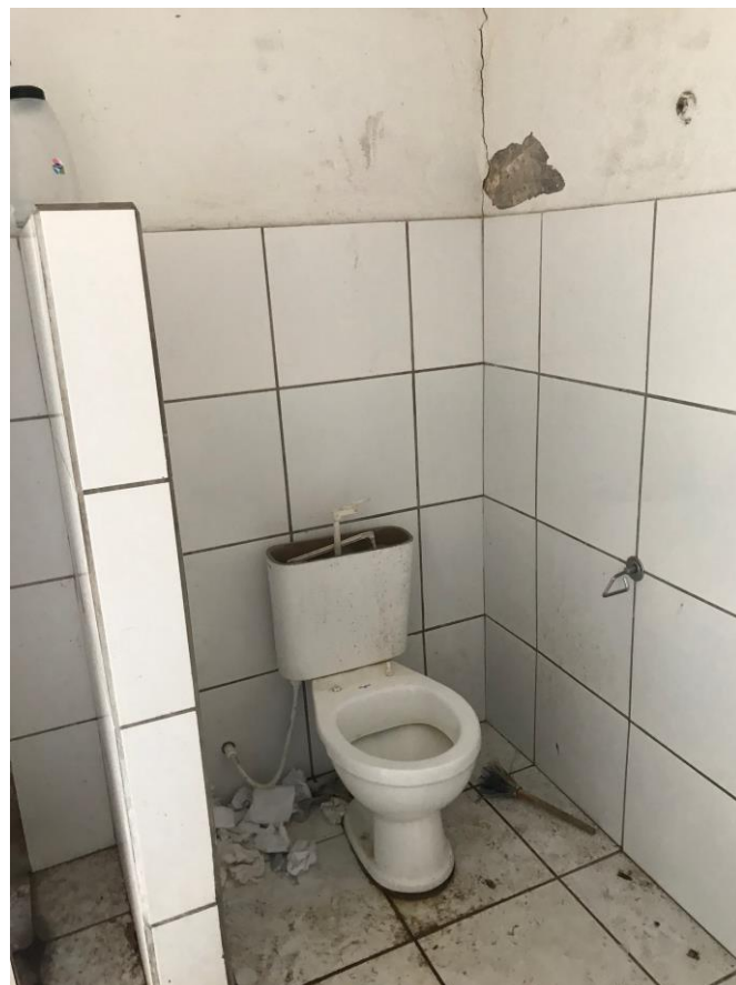
Imagem 17 – Foto tirada in loco em um dos banheiros. Fonte: COPROJ-SEINF.
