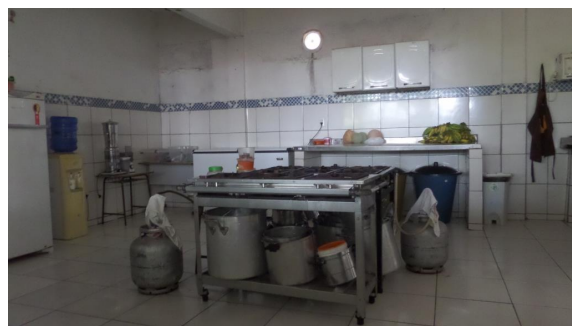
Figura 5 e 6 – Quadro de Energia e Cozinha
