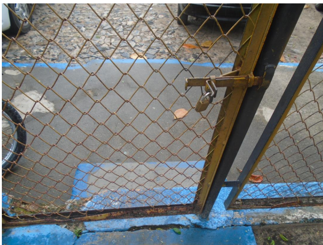
Imagem 20 – Foto tirada in loco do portão/gradil de ferro na entrada. Fonte: COPROJ-SEINF.
