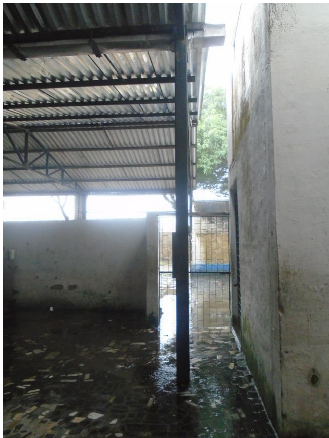
Imagem 25 – Imagem da cobertura metálica atual. Fonte: COPROJ-SEINF.
