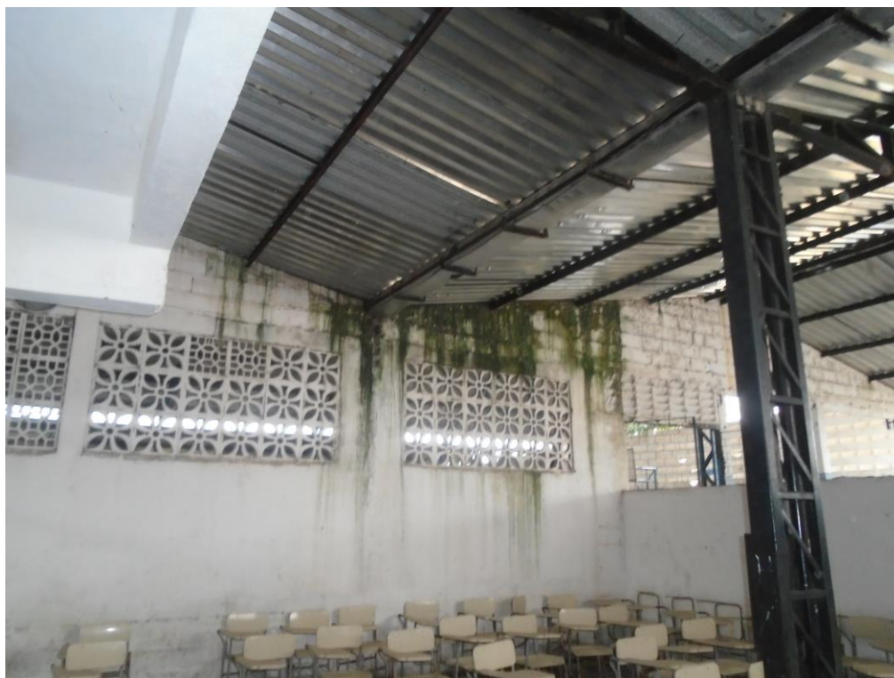
Imagem 11 – Foto tirada in loco da cobertura metálica. Fonte: COPROJ-SEINF.
