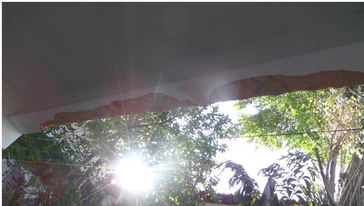
Imagem 08 – Foto tirada in loco da viga do primeiro andar. Fonte: COPROJ-SEINF.
